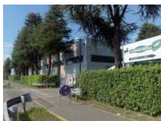
Lo stabilimento di Casalmaiocco
